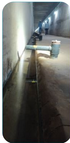
Drenos da barragem de Itaipu
